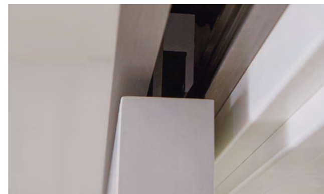
Befestigung einer Holztür im Schiebetürbeschlag SLIM
